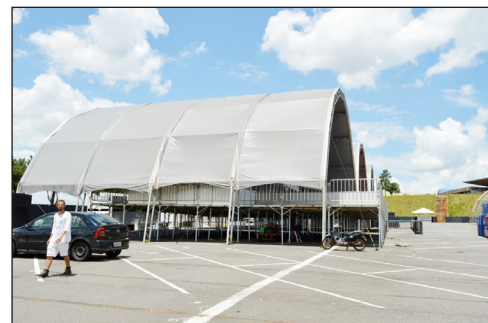
Durante a fiscalização, foi identificado serviços regularizados de execução de: aterramento, instalação elétrica, iluminação, montagem e desmontagem de estrutura metálica e de palco, projeto arquitetônico e de combate a incêndio
